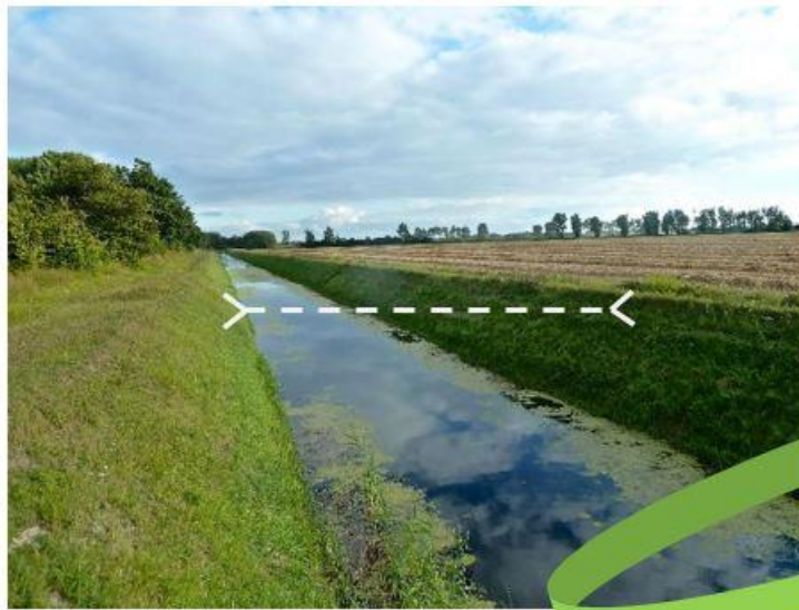
Naturfernes, kanalisiertes Gewässer Foto: Stephan Naumann
